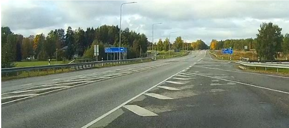
Foto 2.2. Näide likvideeritud parempöörderajast riigiteel nr 3 Kõrvekülas
