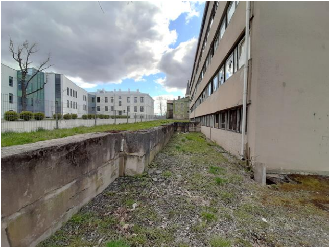
Foto 9 Vaade idast lõuna suunas
