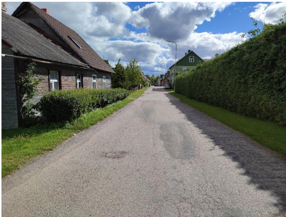
Pilt 1. Vaade piki Väike tänavat Tartu tänava suunas. Tänaval puuduvad kõnniteed, domineerimas on kruntide haljastus ja looduslähedane miljöö.
