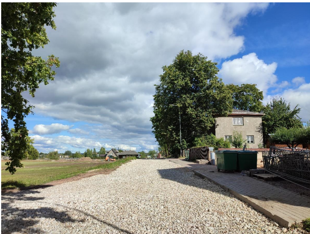
Pilt 4. Roosi tänava remonttööd 2022. aastal. Tänavahaljastus puudu (pildil vasakule jääb staadion).
