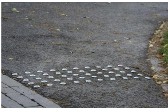
Foto 3-4. Kleebitavad taktilsed tähised olemasolevatel teekatenditel.
