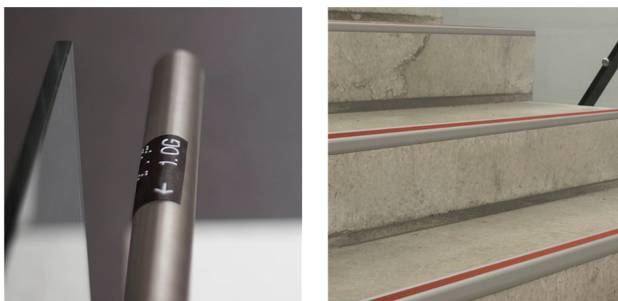
Foto 5-6. Trepil info punktkirjas käsipuul ja astmete tähisribad.
