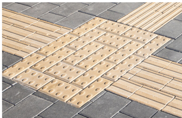
Foto 1. Betoonist taktilne hoiatuskivi plaat 300x300x60 mm (Rae Kivitehas). Foto 2. Betoonist taktilsed hoiatuskivid 200x100x60 mm, värv kollane (Prizma 6D, Betona Mozaika).
