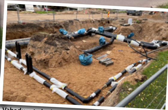
Vabaduse tn katlamaja rõhutõste sõlme rekonstrueerimine. Foto: Danpower Eesti AS
