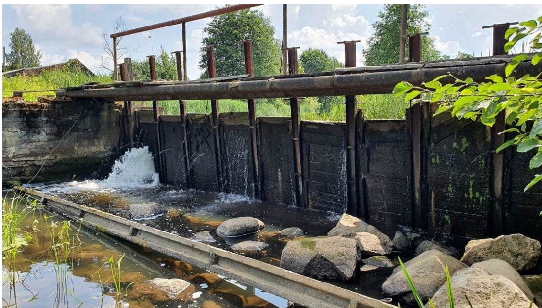
Joonis 3.2.20. Paidra paisu puidust regulaator.
