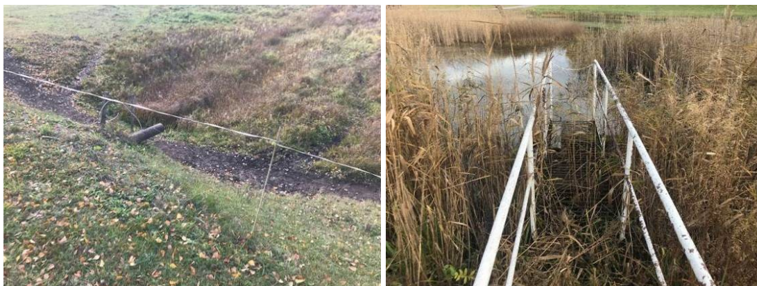
Joonis 3.3.34. Teealune toru (vasakul) ja veetaseme regulaator (paremal).
