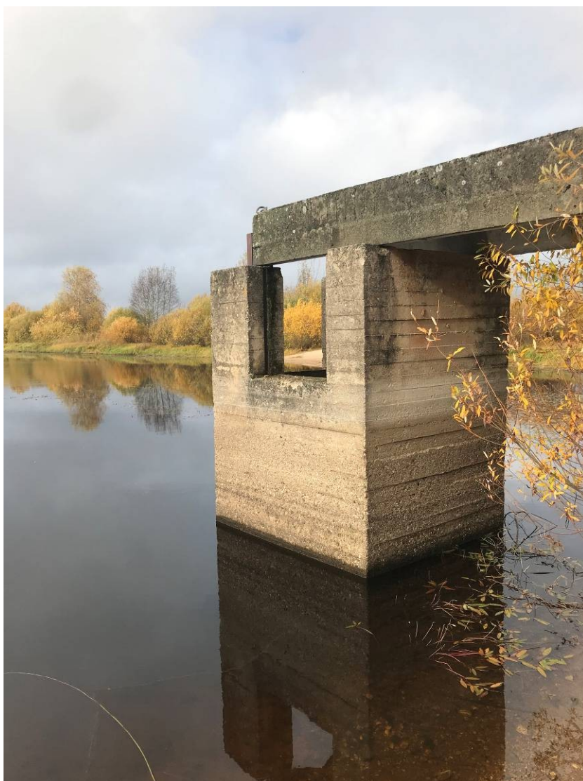
Joonis 3.3.25. Veetaseme regulaator.
