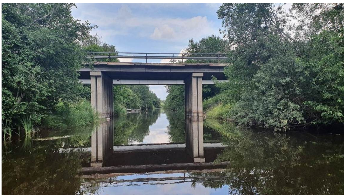
Joonis 3.2.2. Sild riigimaanteel nr 2 üle Liitva kanali.
