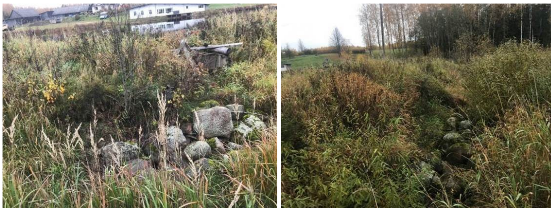
Joonis 3.3.14. Väljavool äravoolukanalisse (vaade põhja, vasakul); ülevoolukanal (vaade itta, paremal).
