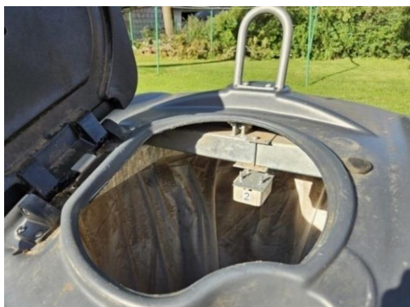
Joonis 28. Süvamahutisse paigaldatud andur, mis kogub ja edastab andmeid konteineri täituvuse kohta 44 .
