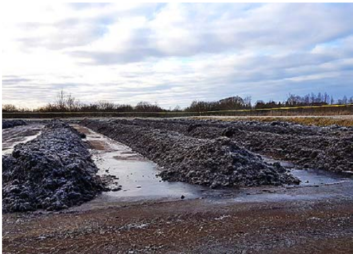
ASi Võru Vesi reoveesette kompostimisväljak. Foto: AS Võru Vesi
