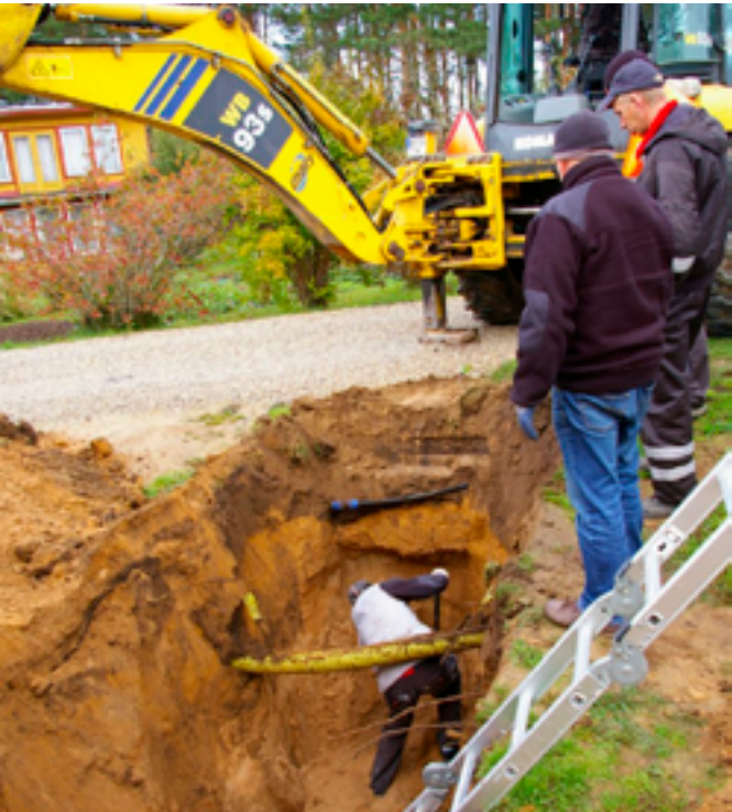
Käimas on ühisveevärgi ja -kanalisatsiooniga liitumine. Foto: Ullis Guth
