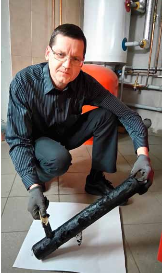
Ilmar Sild osutab filtrielemendile ladestunud mustale kleepuvale massile ehk magnetiidile, mis on tekkinud kõigest mõne kuuga.
