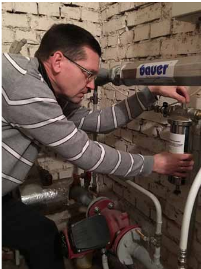
Oma majas vahetab Ilmar Sild keskkütte püsiläbipesuseadme filtrit paaril korral aastas. See on ka ainuke, pealegi lihtne töö, mida on vaja seadme hooldamiseks teha.
