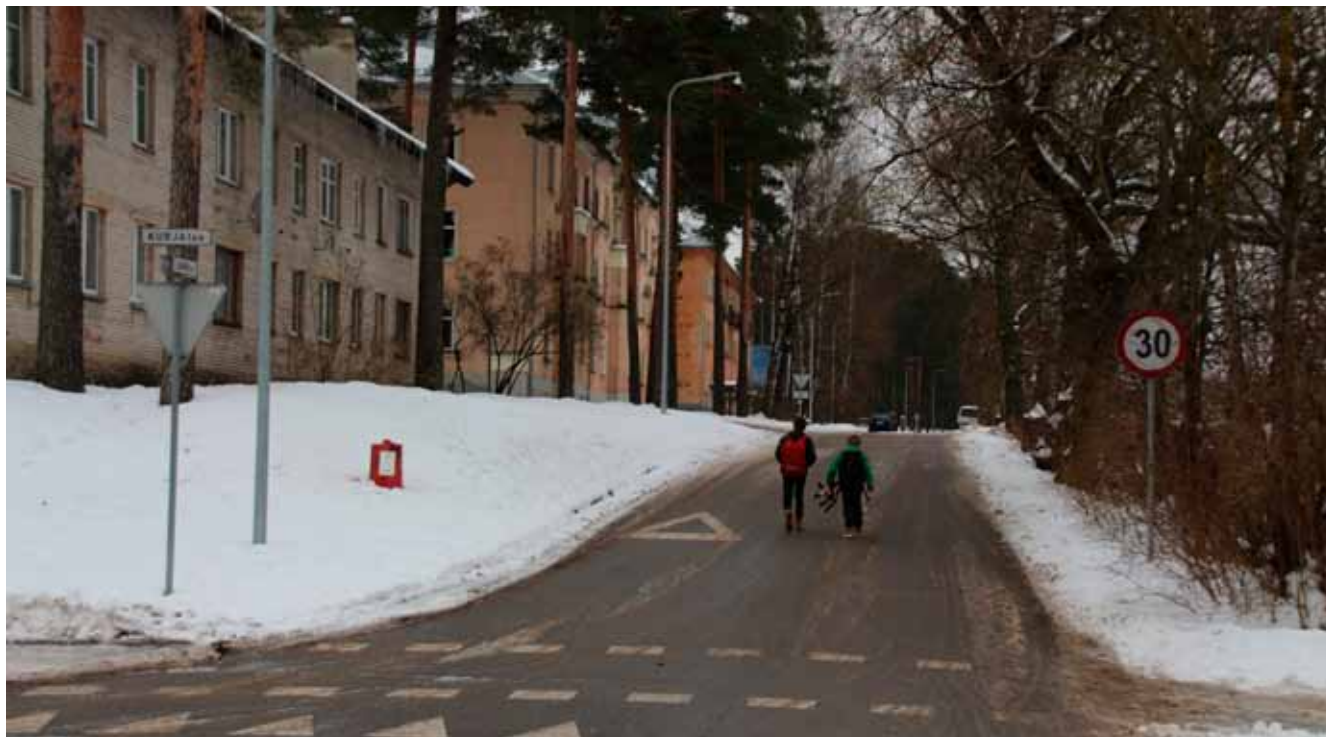
Laane tänava algus nädal tagasi. Tuleval aastal jätkub tänava asfalteerimine ja pindamine ning majadega külgnevale alale rajatakse jalg- ja jalgrattatee.
