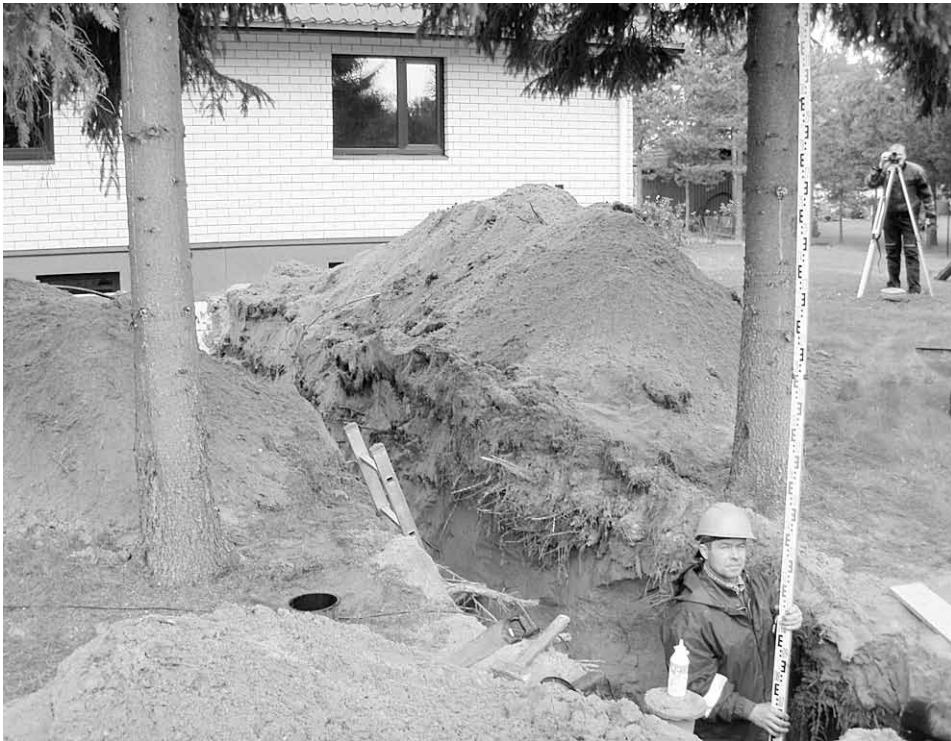
Kanalisatsiooni ja veetorustiku ehitus kinnistul.
