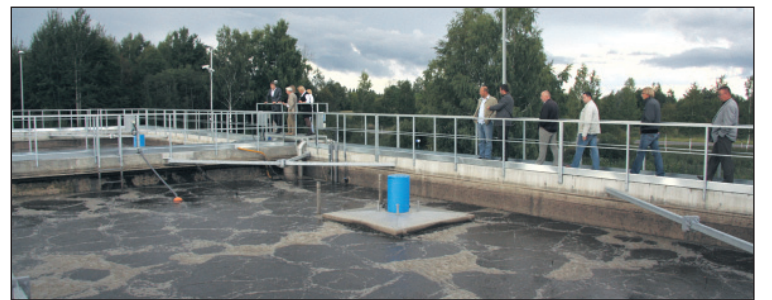
Uuenenud ja kaasaegne reoveepuhasti.
