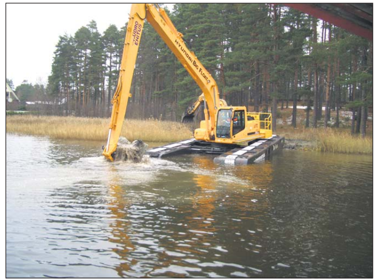
Töid teostati Eesti esimese ujuvekskavaatoriga Hyundai Big Float.
