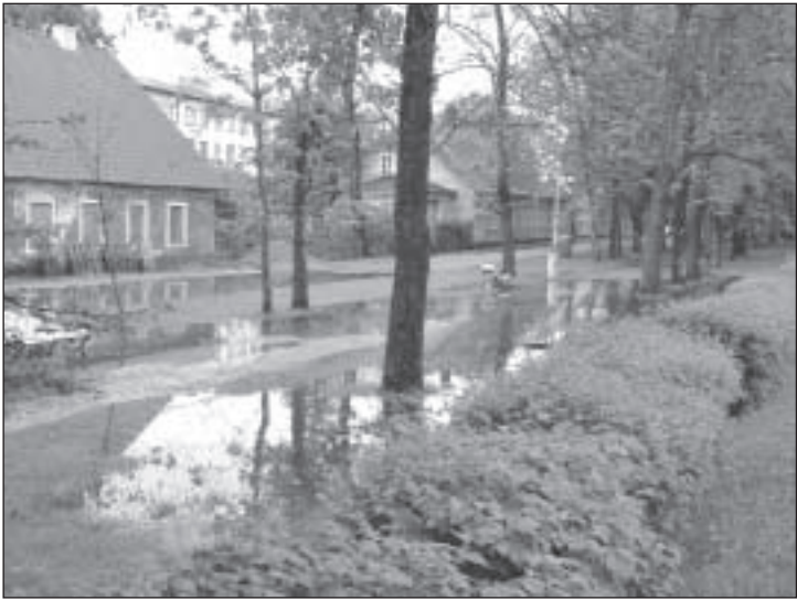
Tõsiseks probleemiks on sademeveekanaliseerimise puudumine Katariina tänaval, mistõttu pole seal suurema vihmaga peaaegu võimalik jalgsi liikuda.
