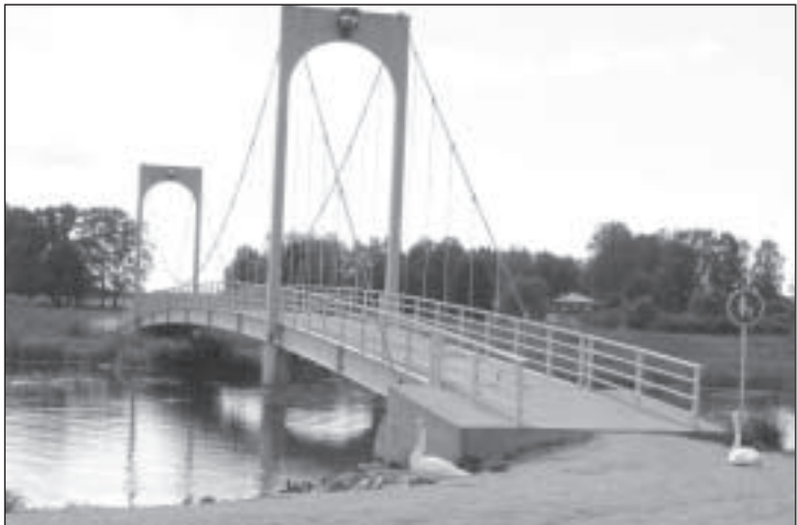
Roosisaare silla ühe külje terastala on pisut vajunud ning sild vajab hooldustöid.
